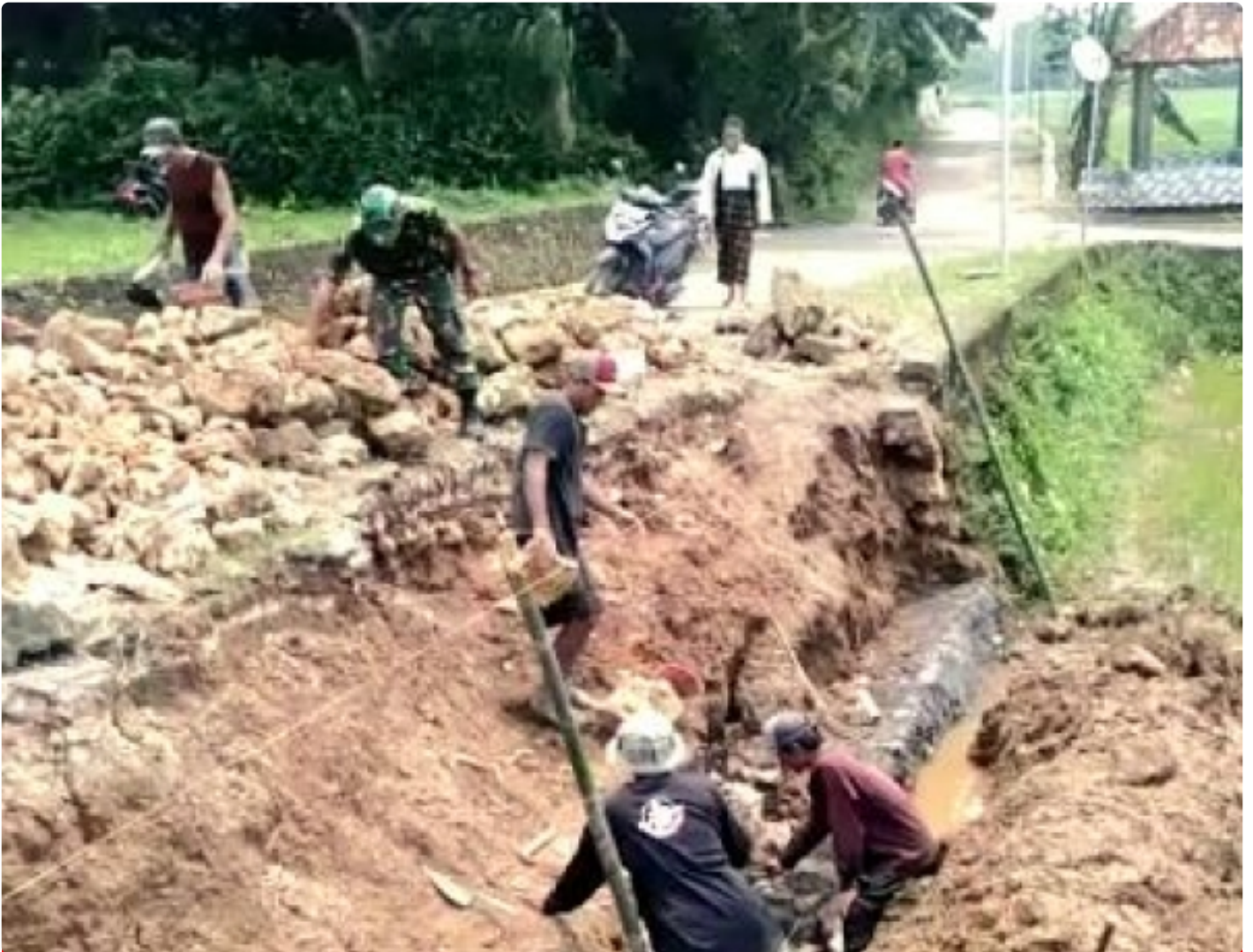
Karya Bakti pembuatan plengsengan penahan jalan
