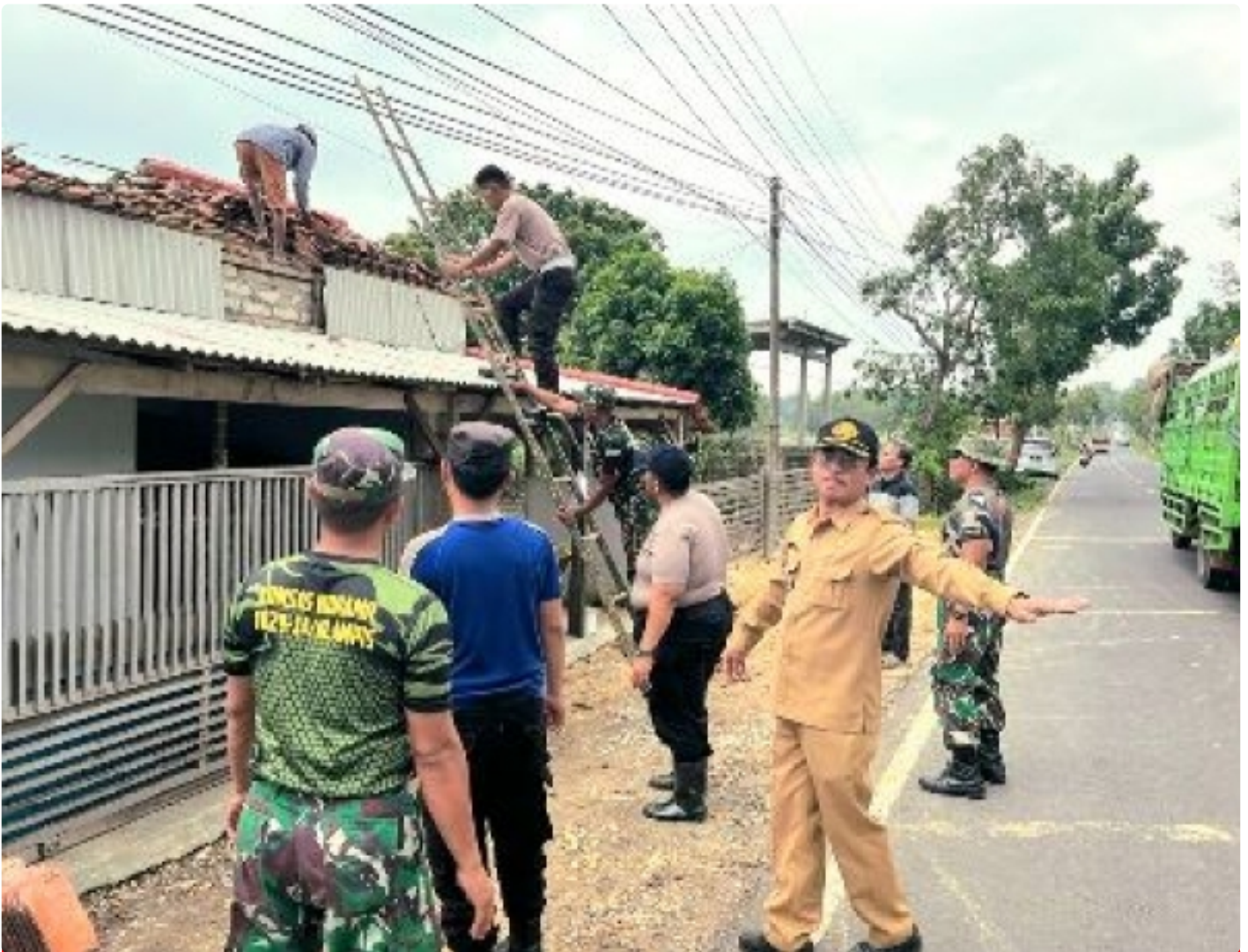
Karya Bakti perbaikan rumah terdampak robohnya tiang listrik.
